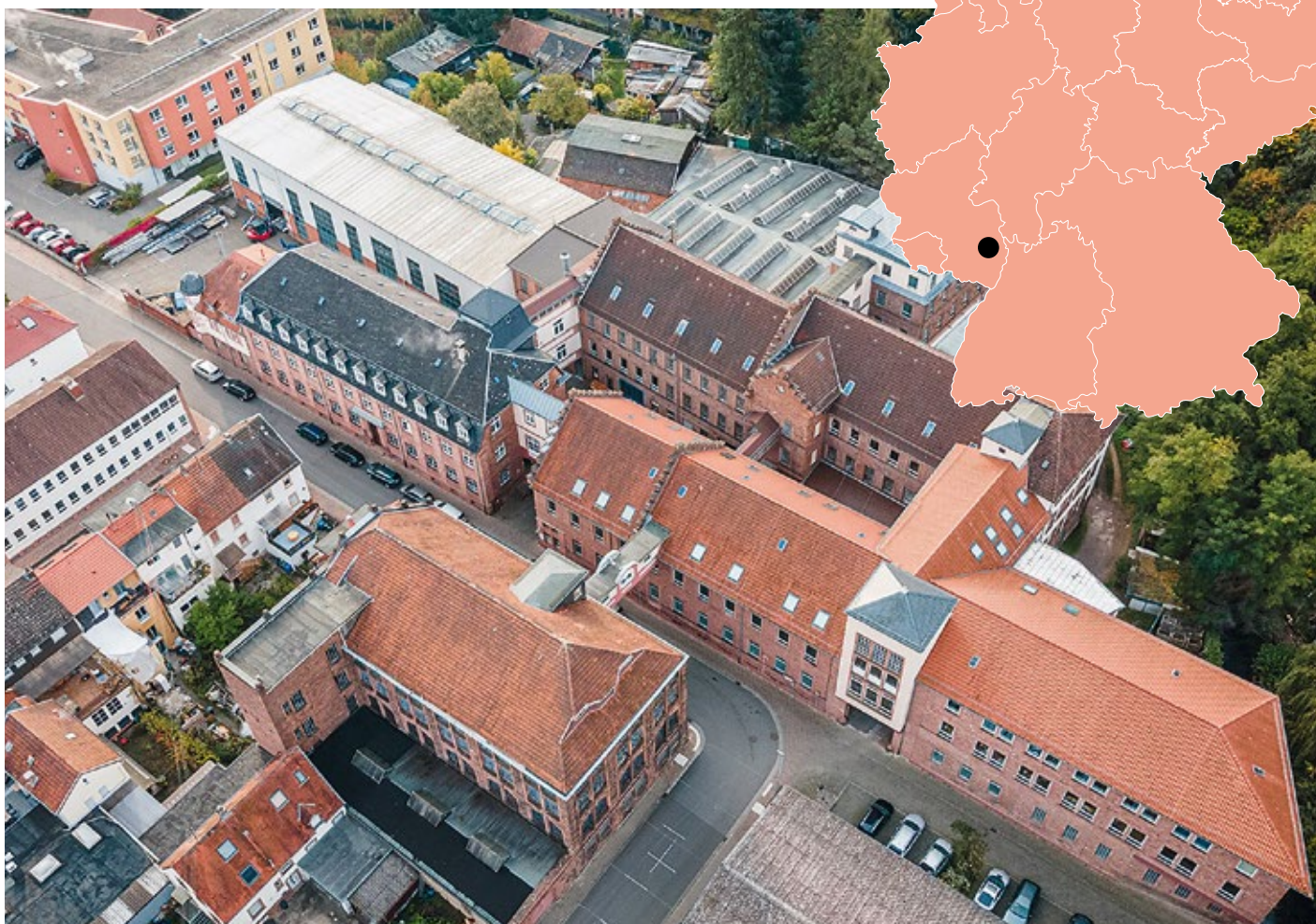
Luftansicht des Unternehmenssitzes, der ehemaligen Tuchfabrik »Gebrüder Haas« | Foto: © Enrico Markx/Jola Spezialschalter GmbH & Co. KG
